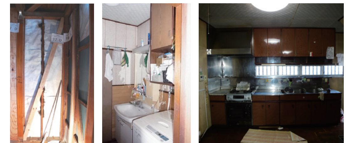
耐震補強の壁
