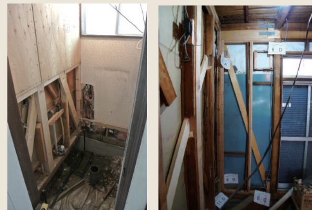
木造住宅の耐震補強
