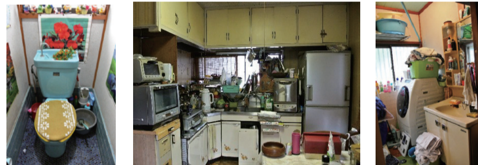
リフォーム前：左からトイレ、キッチン、洗面室
