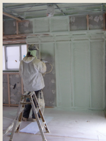
外壁面へ発砲ウレタン断熱の吹き付け
