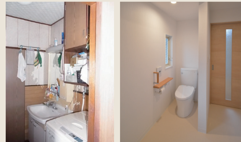
Before：既存の洗面も狭くて介護向けとはかけ離れていました。トイレは洗面と一室になっており、あえて扉を設けていません。
