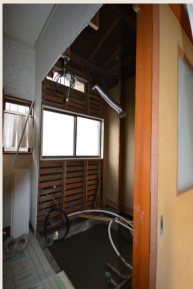
浴室リフォームは洗面室の壁にも及ぶ。
