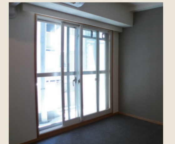
After: 掃き出し内窓の設置
