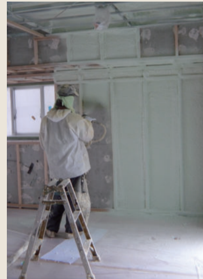
施工中：断熱材吹付
