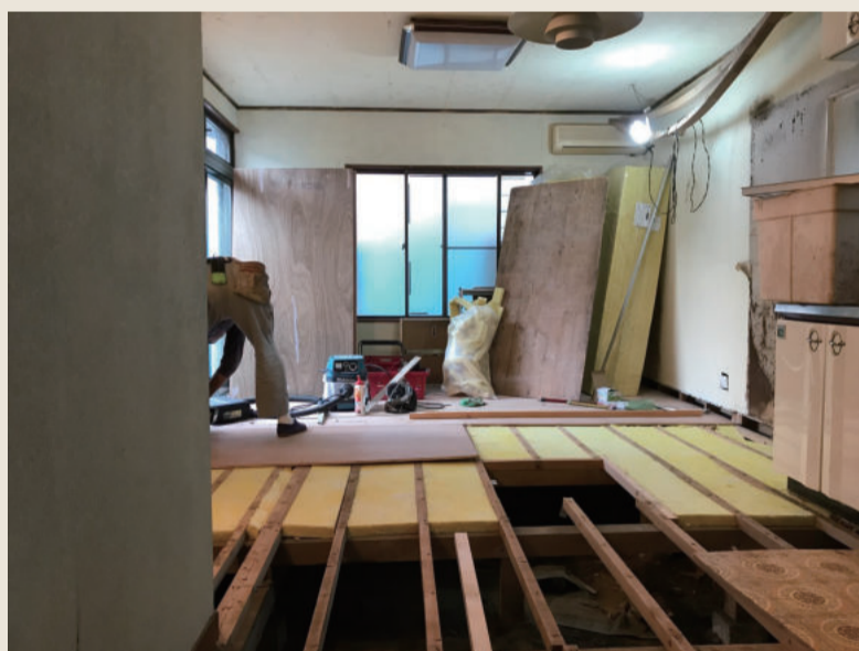
施工中：床の断熱材入れ
