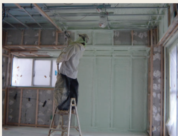
外壁・天井への断熱材の吹付
