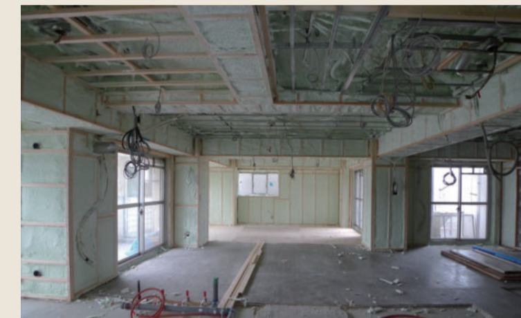
施工中：壁・天井断熱工事完了
