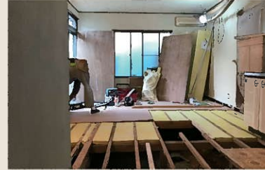
施工中：断熱材の敷き込み
