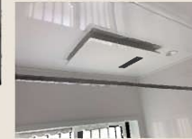
After：浴室暖房乾燥機
