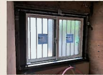
施工中：内窓の設置
