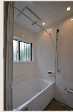
After：暖かい浴室が完成しました。
