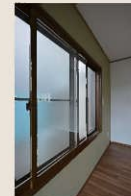
After：内窓の設置
