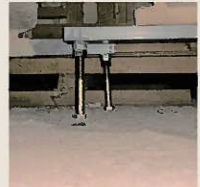
向かいの浴室から配管と配線をもってこれれば！
