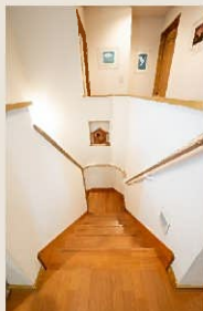
After：階段手すり設置
